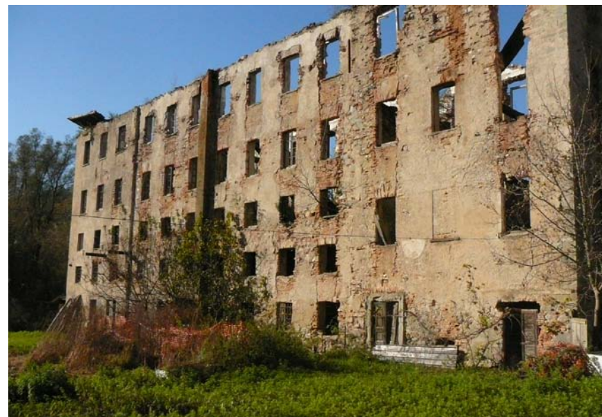
Figura 16 - Prospetto dell'ex filatoio di seta Maggi, così come si presenta oggi.
